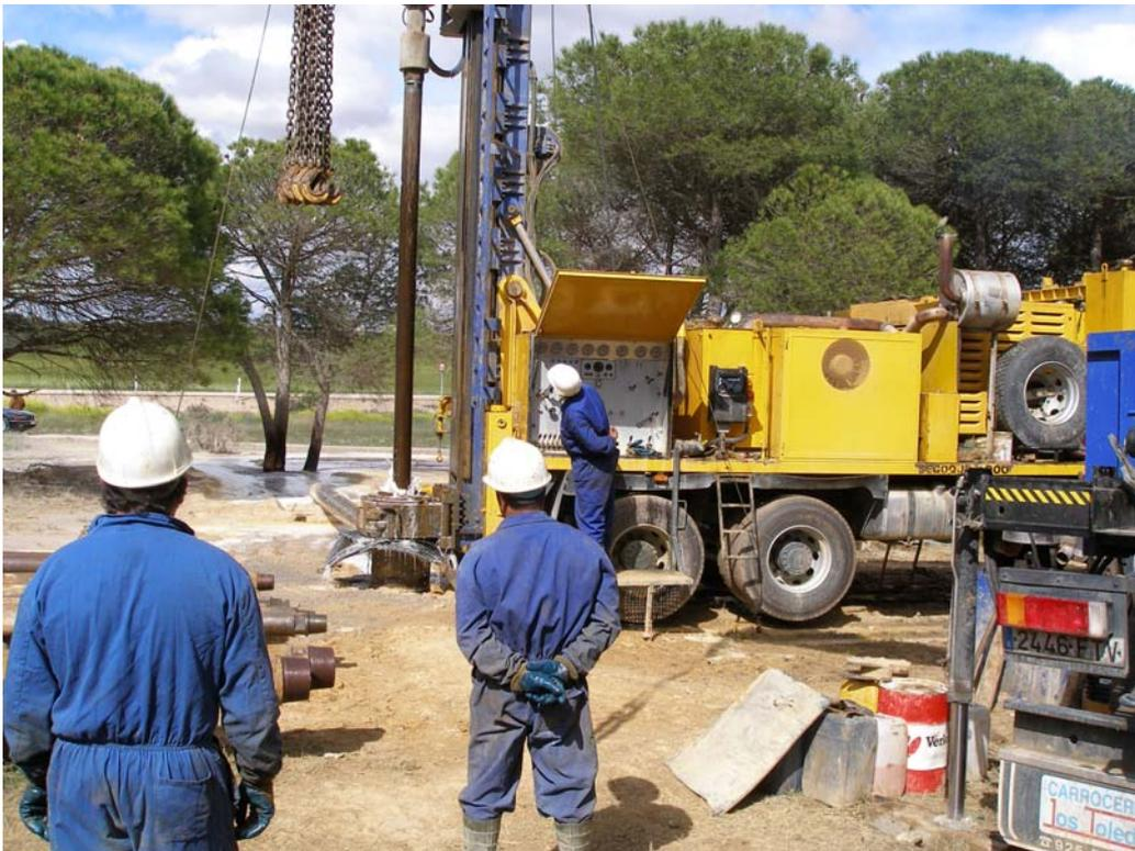
**Figura 2** .- Perforación del sondeo de la Almarcha 2. Enfrente se puede observar la perforación del sondeo Almarcha-1.
